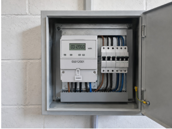
Фото 5 · Внутри · Дата съёмки: 01.11.2026
