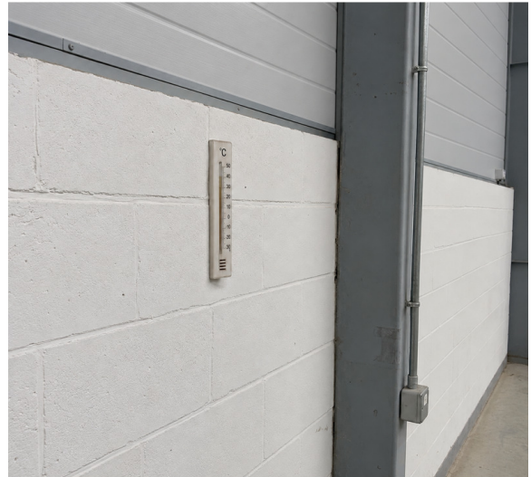
Фото 6 · Внутри · Дата съёмки: 01.11.2026
